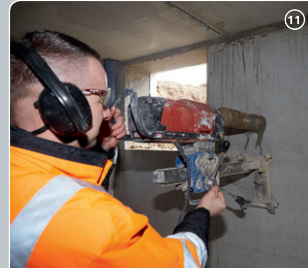
11 Kai-Uwe Loberenz und seine Kollegen legen den Anschluss durch die Hauswand.
