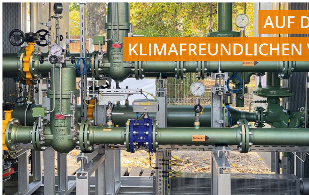
Wasserstofftaugliche Gasdruckregelstation in Berlin-Lichtenberg
