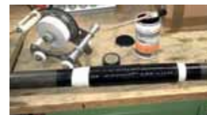
nach erfolgreicher Prüfung, Verkleidung zulässig
