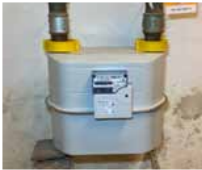
Anbindung Gaszähler ans intelligente Messsystem NBB Netzgesellschaft Berlin-Brandenburg mbH & Co. KG
